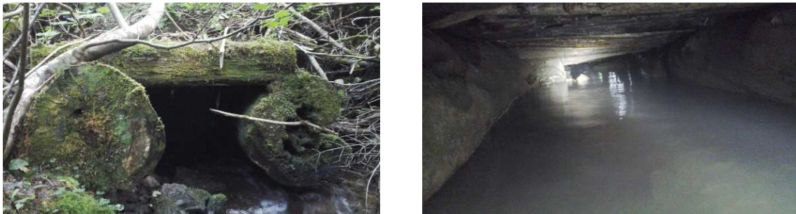
Figure 6 - Exemple d'un ponceau de bois typique (extrémité à gauche et intérieur à droite)
