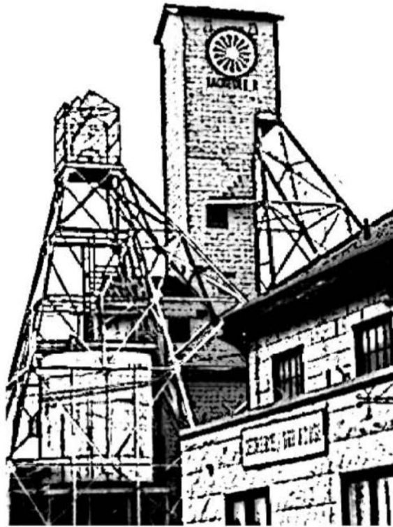
Figure 6.1 b Site historique de l'Ancienne-Mine-Lamaque
